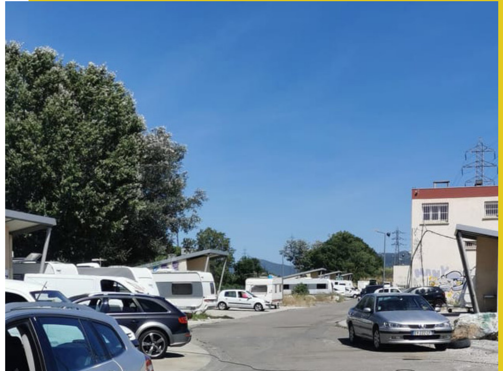
Aire d'accueil, située à Saint Menet (13), entourée d'un site SEVESO, d'une autoroute, d'une centrale électrique, d'une décharge et d'un terrain de motocross.
